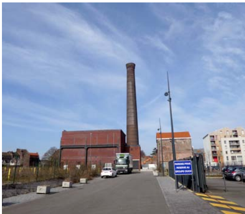
↑ TOURCOING, cheminée de la Tossée
