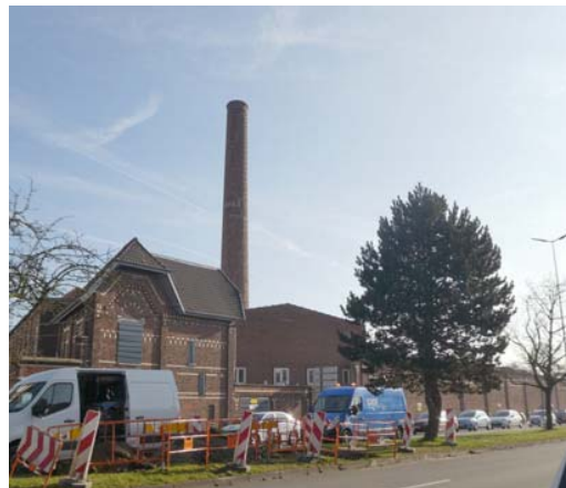
↓ TOURCOING, cheminée Louis Lepoutre
